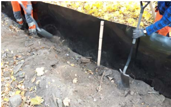
Abb. 8 / Beispiel: Herstellung Reptilienschutzzaun (glatter Folienzaun) mit fachgerechter Bodeneinbindung 20-30cm
